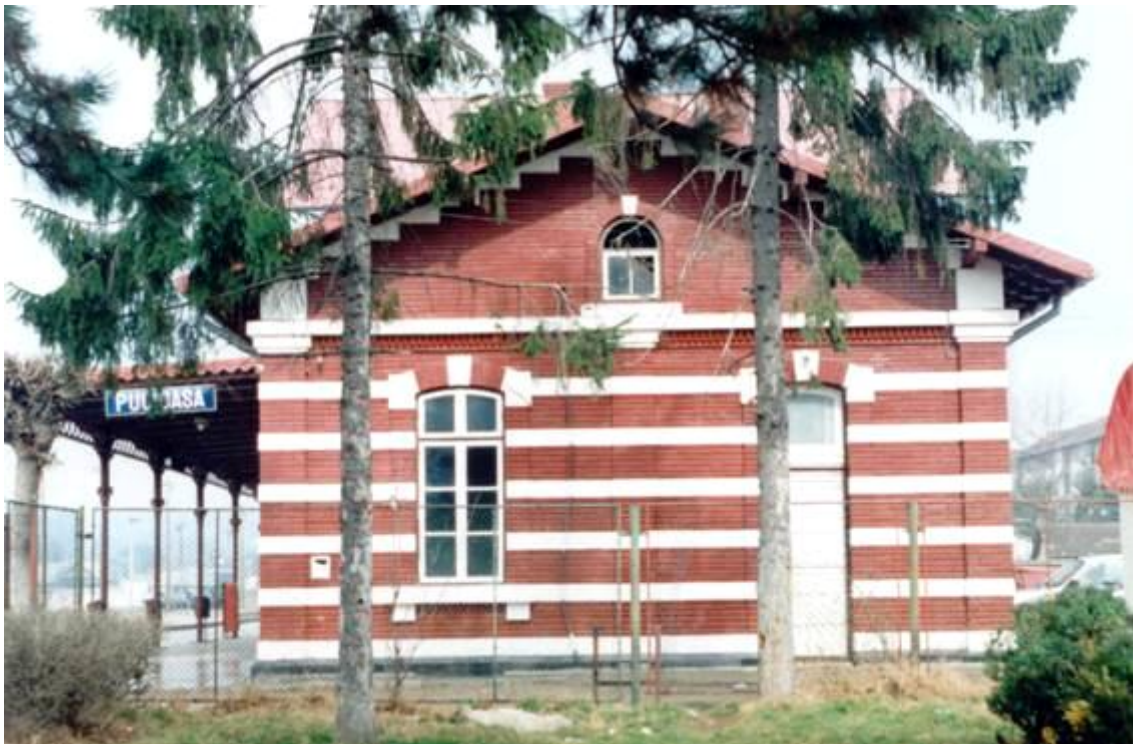
Gara Pucioasa, construită între anii 1893-1894 cu cărămidă de Ciurea
