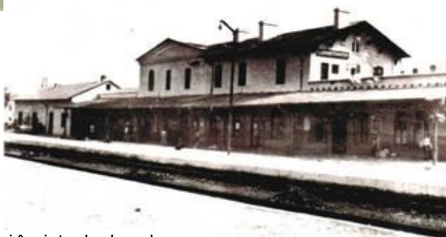
Gara Constanța la 1909 și înainte de demolare
