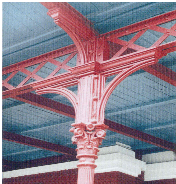
Detaliu de copertină peron la Pucioasa
