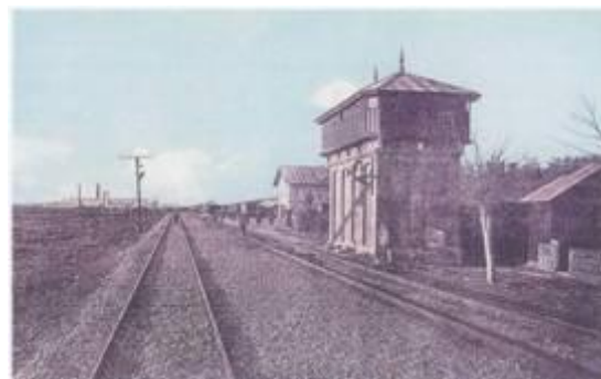
Castelul de apă din stația Buhuși
